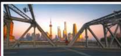
สะพานวอไปตู้
